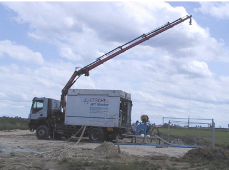
Abb. 3 – Die Behandlung der Brunnen mit dem JET Master erfolgte am „jungfräulichen“ Brunnen.
