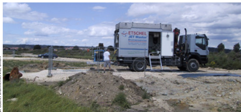
Abb. 2 – Erzeugung von Druckwellenimpulsen durch Wasserhochdruck mit dem JET MASTER
