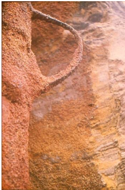
Verockerung an Zentrierung und Bohrlochwand
