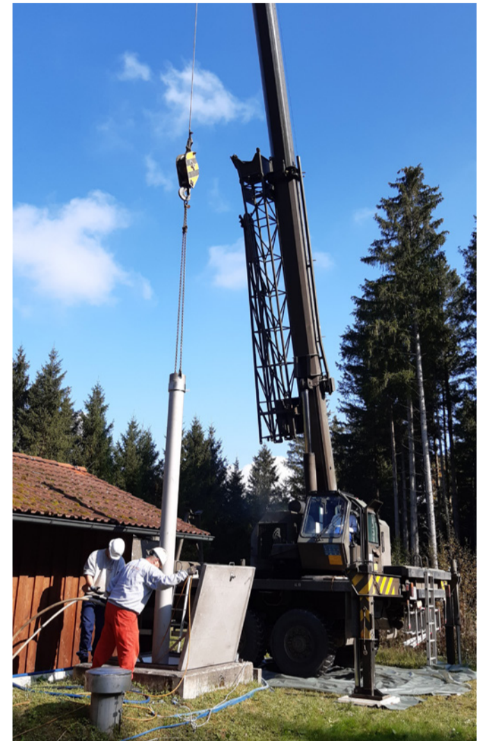
Bild 2: Pumpenwechsel
