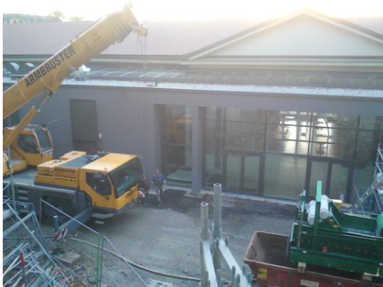
Abb.: Abtransport des zwei Tonnen schweren Rüttelsiebes durch einen Autokran zum Abschluss der Baustelle.
