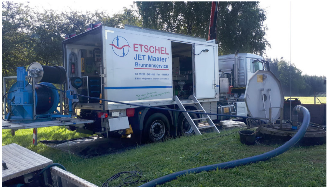
Bild 1: DWI-Regenerierung beim Tiefbrunnen 1 Aichhalden
