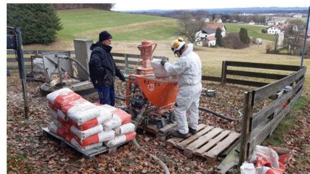
Bild 4: Einbringen von Dämmerzement
