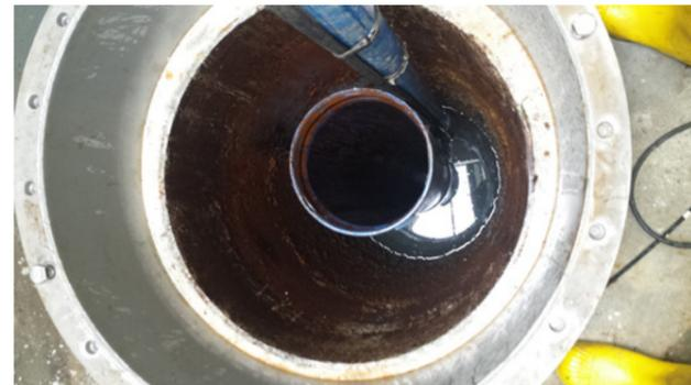
Bild 2: Abgesaugter Ringraum
