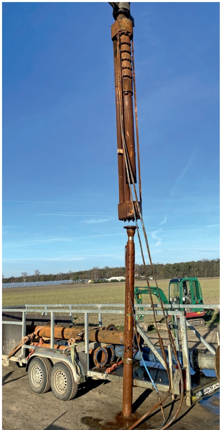
Abb. 3 – Pumpen und Steigleitungen der zu regenerierenden Brunnen waren stark verockert.
