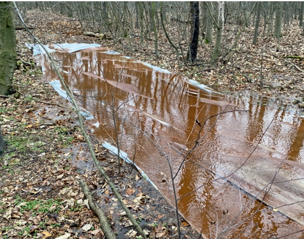
Abb. 4 – Bei der Regenerierung der beiden Brunnen wurde eine beträchtliche Menge an Feststoffen ausgetragen.
