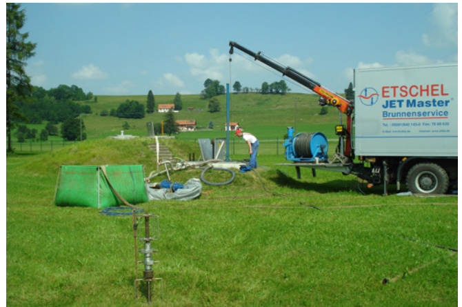
Bild 3 : Regenerierung mit dem Druckwellenimpulsverfahren mit Wasserhochdruck, System JET Master®
