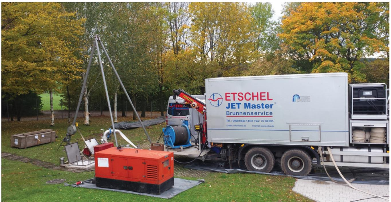
**Bild 1:** Regenerierbaustelle Mering, Druckwellenimpuls-verfahren mit Wasserhochdruck inkl. Rotationsdüse „MAXINOZ®“ im Praxiseinsatz
