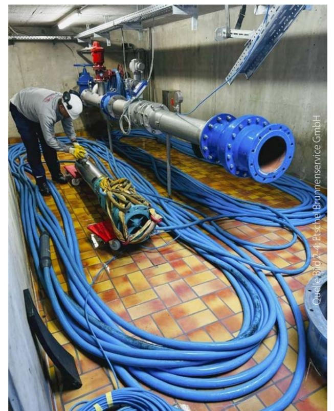
Bild 2: Pumpenkabel nach Ausbau
