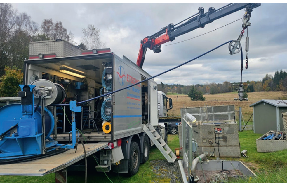
Abb. 4 Druckwellen-Impulsverfahren mit Wasserhochdruck
