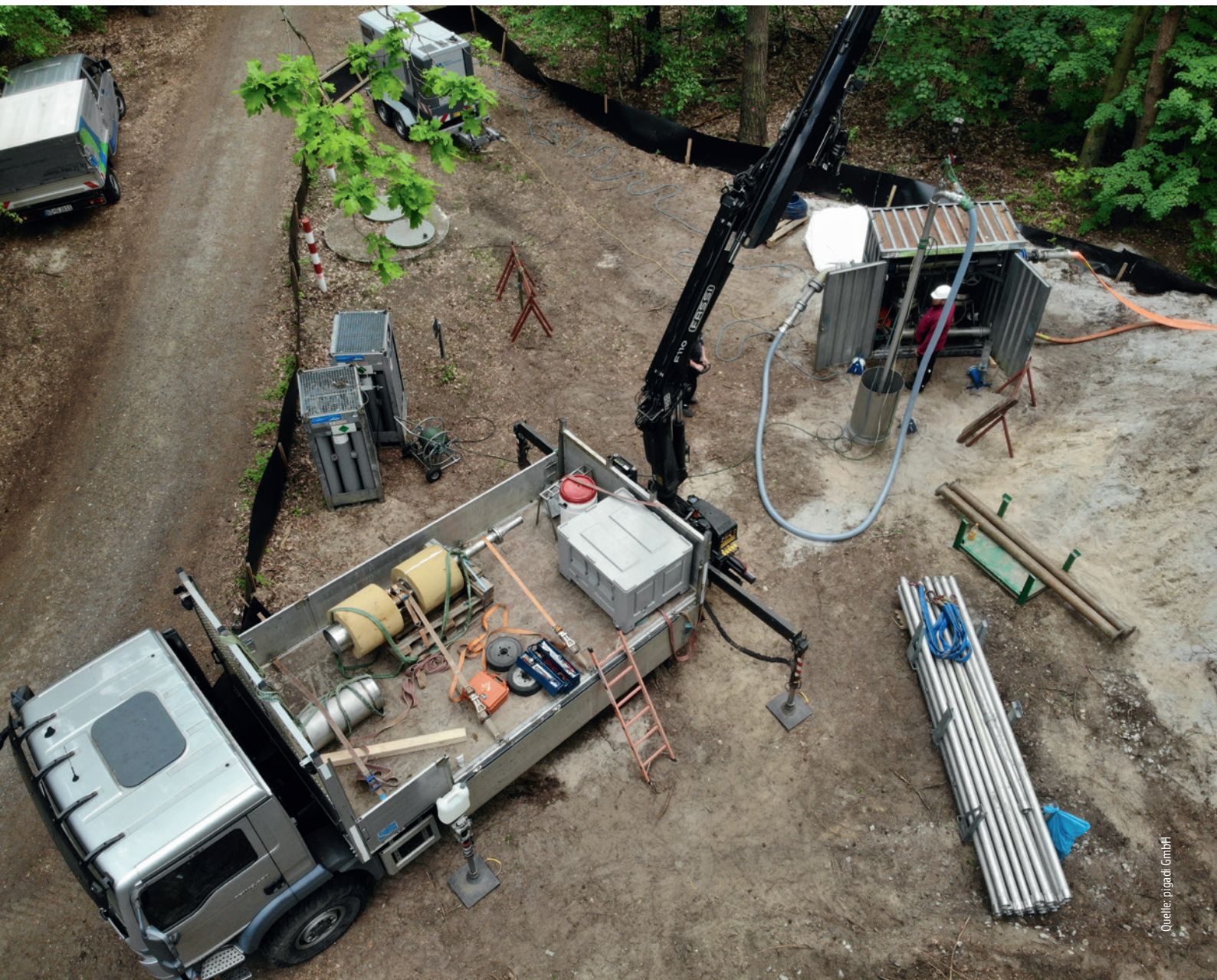
Abb. 1 Entwicklung eines Neubaubrunnens
