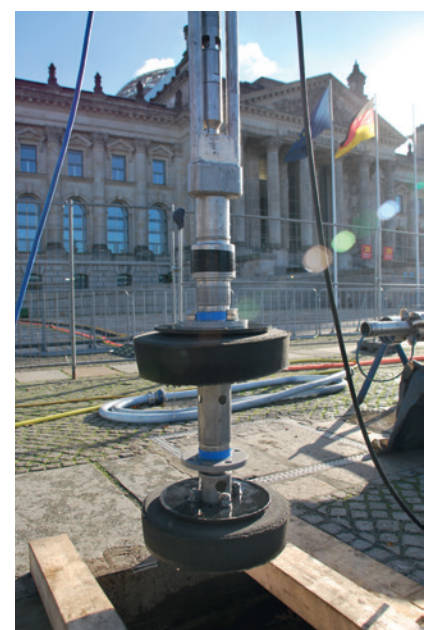
Abb. 5 Druckwellen-Impulsverfahren mit Gas
